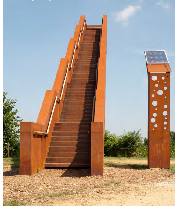
Escalier toure en acier à Tielst-Winge – Lauréat Concours Construction Acier 2014 Cat. C – Concept : Close to bone – Photo : jvdb Infosteel
