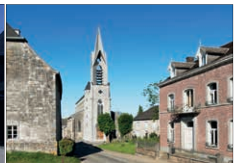
Eglise Saint-Martin à Ferrières, Bureau Greisch, photo Jean-Luc Deru (Photo-Daylight)
