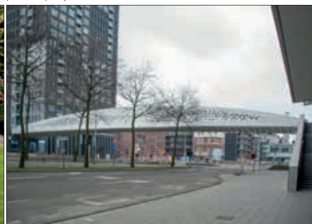
'Parkbrug' à Anvers, Ney & Partners, photo Jo Van den Borre (Infosteel)
