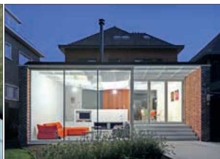
Rénovation d'une maison, ORG PERMANENT MODERNITY, photo Filip Dujardin
